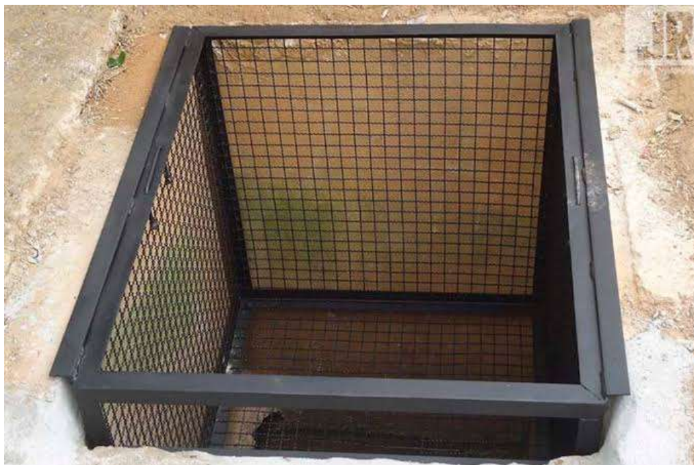
Estrutura modelo de caixa coletora de resíduos sólidos
