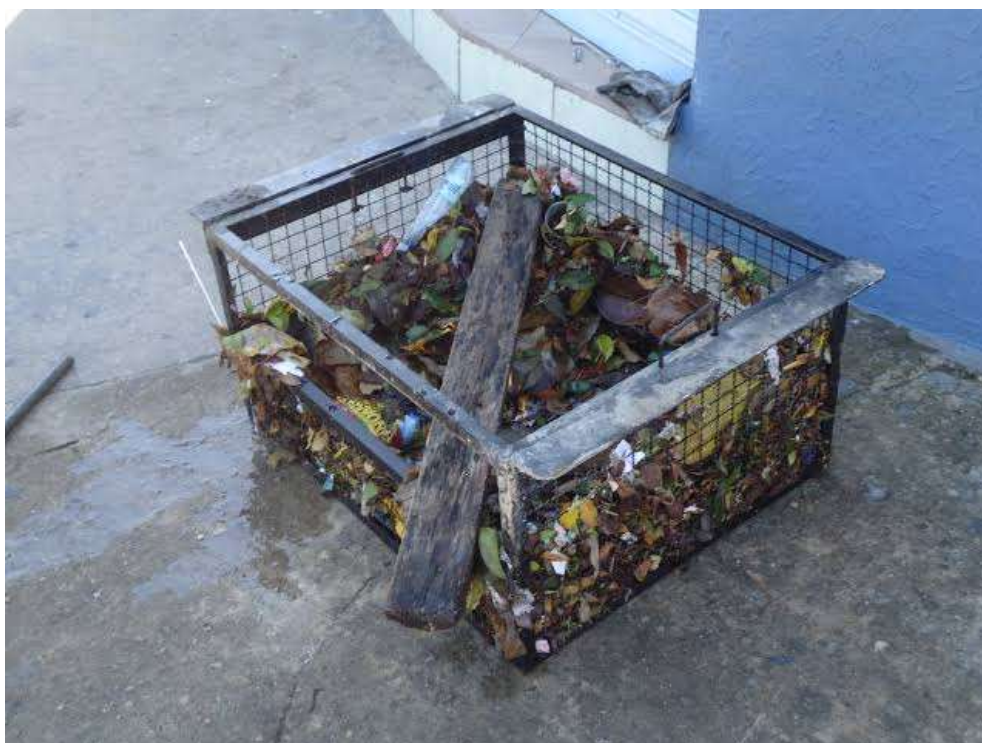
Exemplo de caixa coletora em funcionamento (após a retirada para inspeção)
